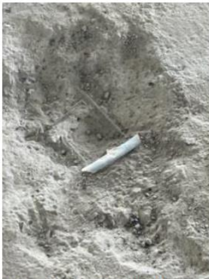
Udsnit af beton udlagt direkte på lyddæk.
