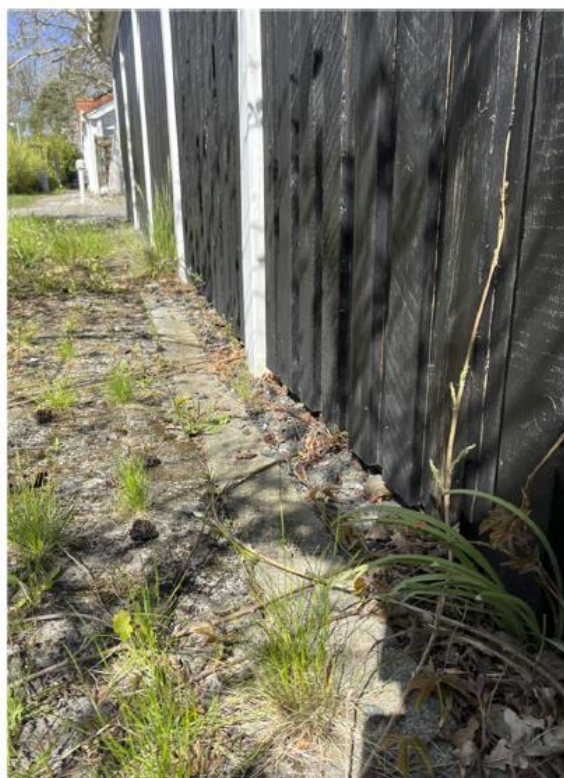
Facade mod syd – beklædning slutter tæt på terræn
