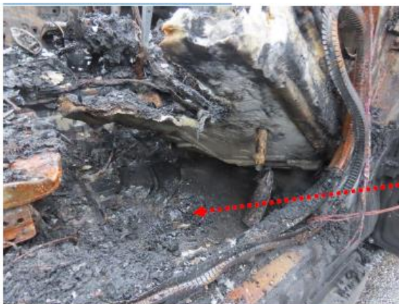
Foto 16 viser undersiden af isolering fra fodrummet foran højre forsæde.
