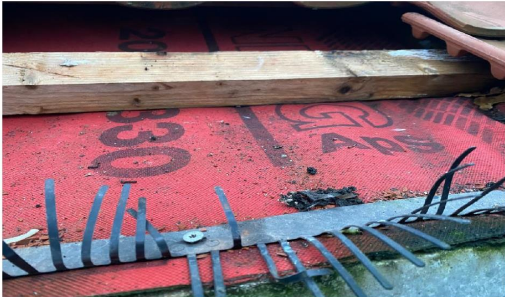
billede nord-øst. Taglægte støder mod hinanden. Her skal være ca 25 mm luft.
