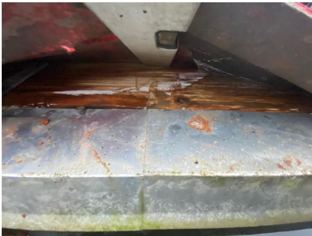
Billede af fodbrædt mod syd-vest. Fodbrædt er vådt og er angrebet af skimmel.
