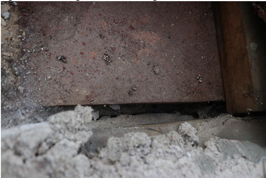
Nyt eksempel på større gab i undertaget
