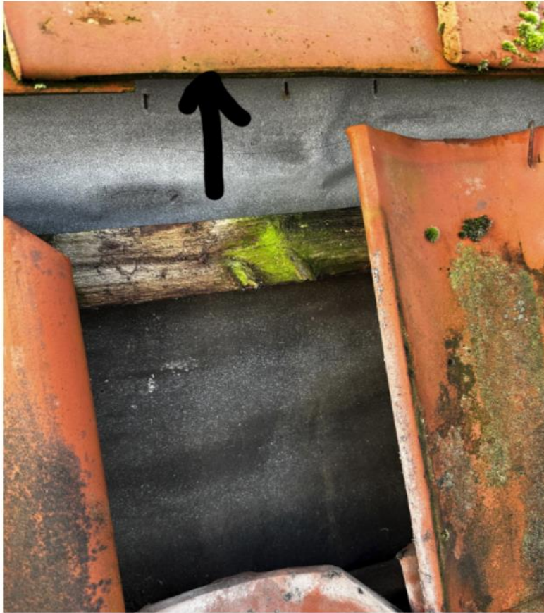
-Eksempel på skadet lægte og for kort undertag og rygning
