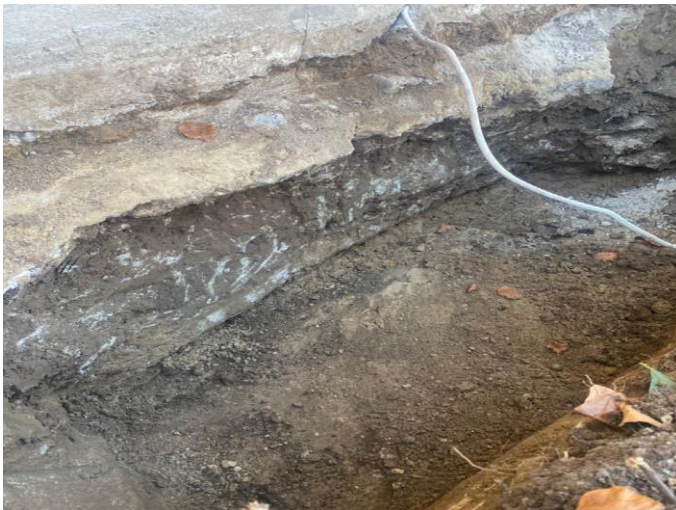
Foto 1: Fundamentsunderkant er 90 cm u.t. Intakte og bæredygtige aflejringer er fundet i funderingsniveauet.
