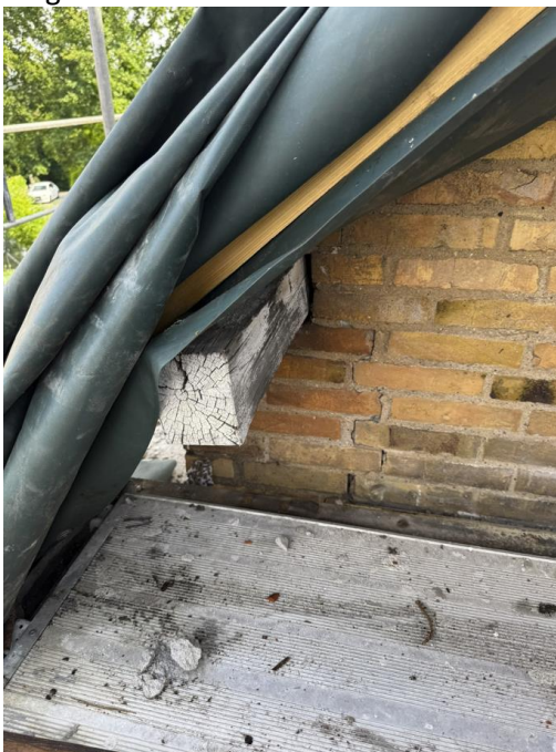
Figure 5: Remmen fremstår forholdsvis intakt med få revner i murværket.
