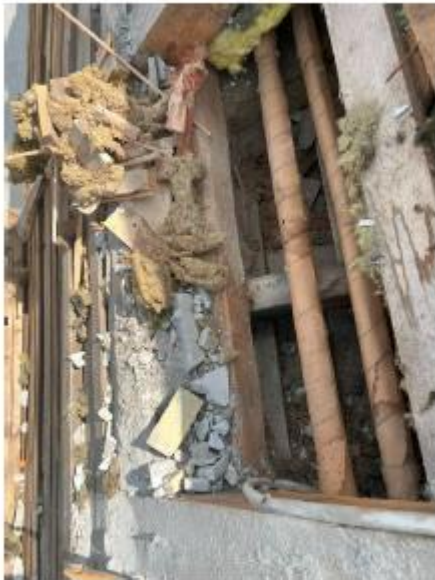
Billede 10 – Opbygning af tagfod
