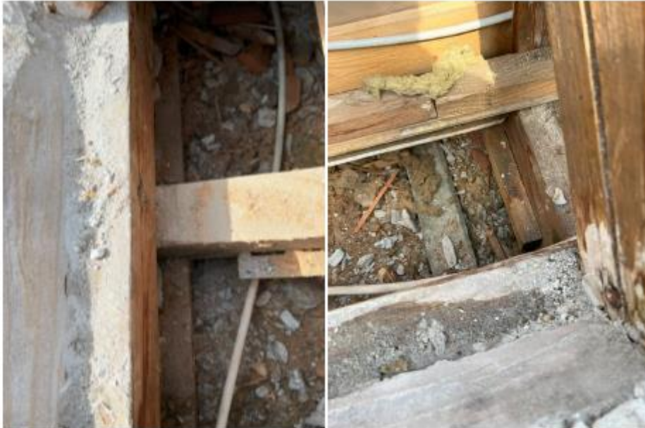
Billede 8 – Ny 4x4" rem placeret ovenpå spærfodsbjælker
