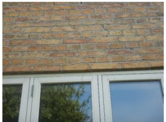
Revne lige over første mursten og fortandning
