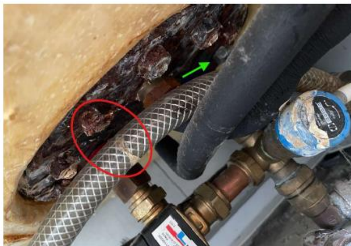
Figur 1 Billedet viser tydeligt, at den "rene" møtrik (grøn pil) sidder langt fra den aktuelle lækage/kalkspor (rød cirkel).
