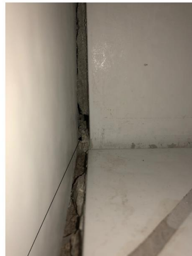
Billede 2. Støbeskellet tæt på. Tydelig revne/manglende støbefuge
