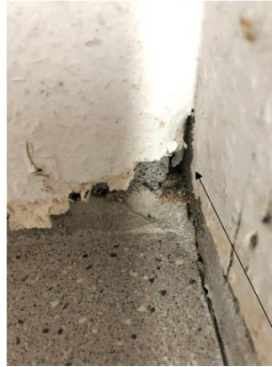
Billede 2. Støbeskellet tæt på. Tydelig revne/manglende støbefuge
