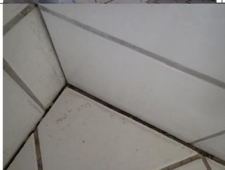
Elastiske fuger er fjernet.
