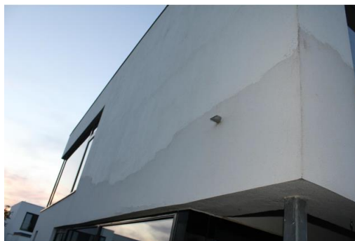
Figure 3: Photo som viser revnedannelse start.
