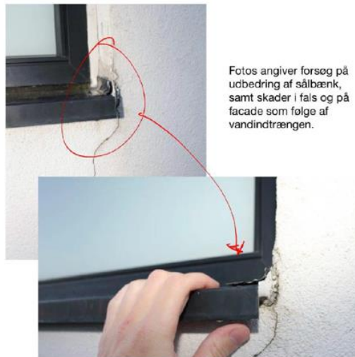
Figure 2: Ved vinduesfals ved overgang mellem fals og sålbænk. Sålbænke er ikke ført ind i pudslag, hvorfor der ved konstruktionssamlingen kan trænge vand ind bag pudslaget, ind i isoleringen.
