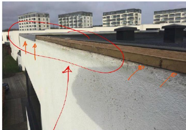
Foto angiver Stern, bag hvilken vand vurderes at kunne trække op bag, og ind bag pudslag.
