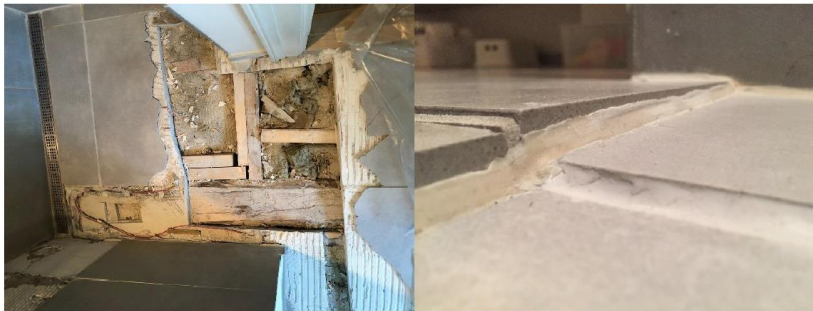
Figur nr. 4 Her ses bjælke og regler/indskud Figur nr. 5 Fliser der er skubbet op
