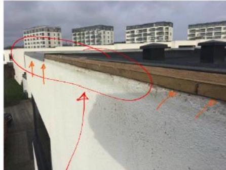
Foto angiver Stern, bag hvilken vand vurderes at kunne trække op bag, og ind bag pudslag.
