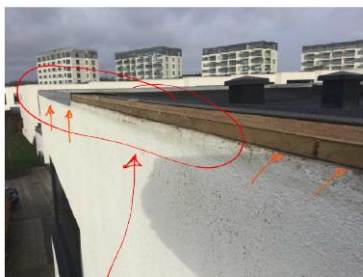
Foto angiver Stern, bag hvilken vand vurderes at kunne trække op bag, og ind bag pudslaget.
