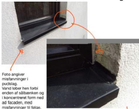
Foto angiver sølbænk med forsøg på udbedring, med påklæbet bånd i hjørne. Sølbænk er ikke ført ind bag pudslag og er udført uden endebund.
