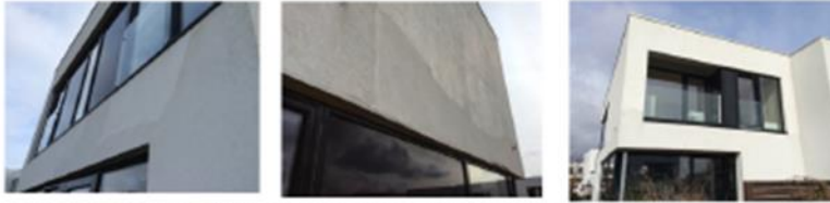
Fotos angiver facader med spor efter udbedringeforsøg
