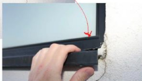
Fotos angiver forsøg på udbedring af sålbænk, samt skader i fals og på facade som følge af vandindtrængen.
