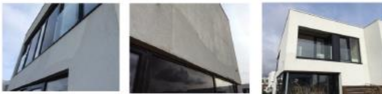
Fotos angiver facader med spor efter udbedringsforsøg
