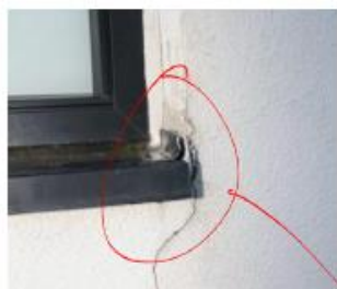
Fotos angiver forsøg på udbedring af sålbænk, samt skader i fals og på facade som følge af vandindtrængen.
