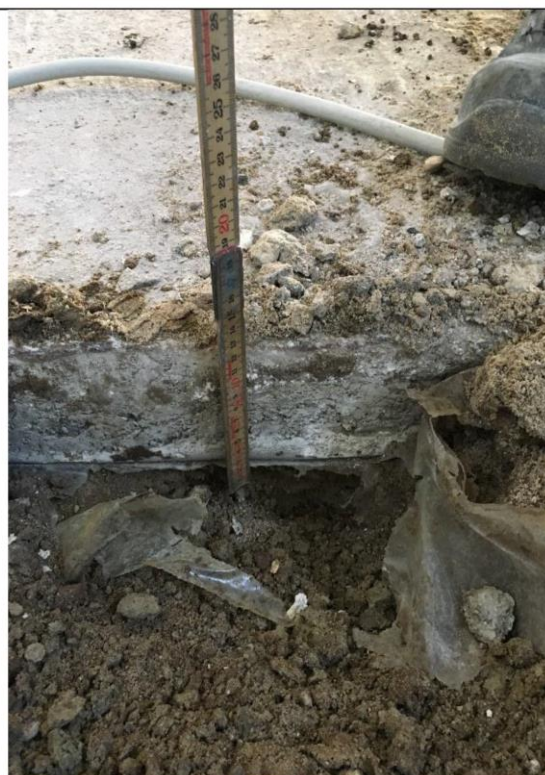
Klaplag i resten af huset tykkere, af bedre kvalitet og med plastfugtspærre.
