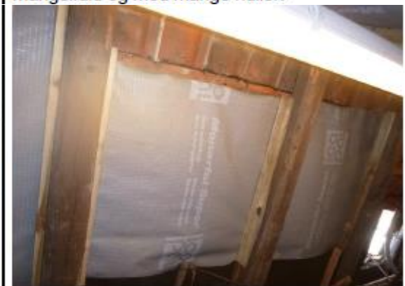
Foto 54 - Udspændt Monarfol varierer fra hanebånd og til ca. 30 cm fra kip eller helt til kip.
