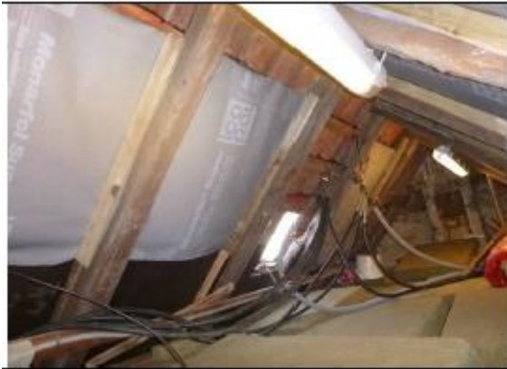
Foto 53 - Udspændt nyere undertag (Monarfol) mellem spær.
