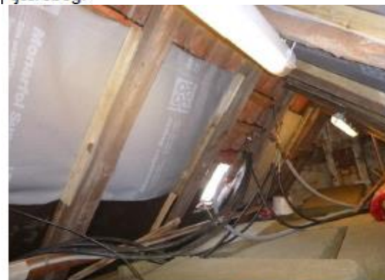
Foto 53 - Udspændt nyere undertag (Monarfol) mellem spær.
