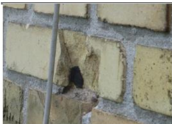
Foto 27 - Frostsprængte mursten i gavl fra nr. 4 mod nr. 6 mod gade.
