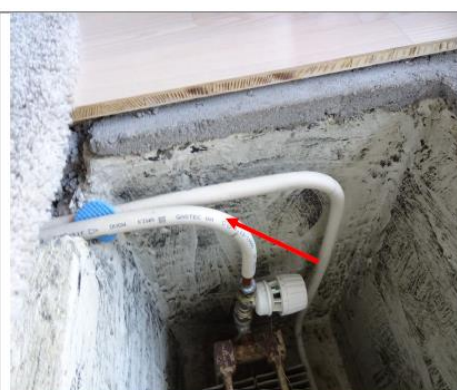
2. Rød pil = Nye varmerør til radiatorventil
