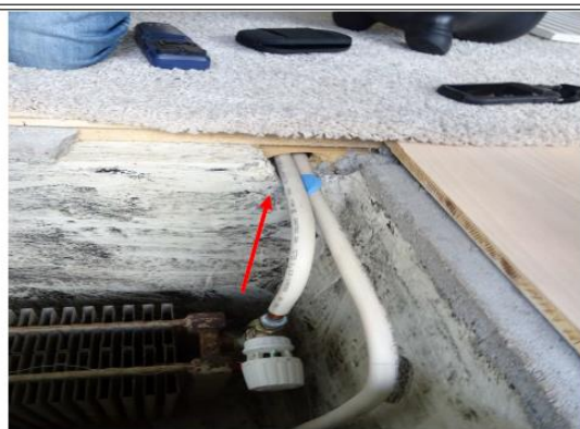
3. Rød pil = Varmerør til radiator i grav
