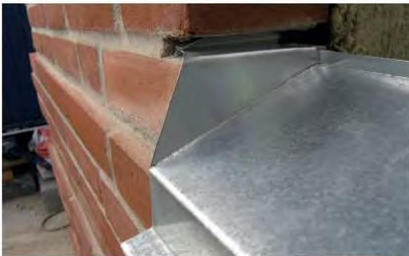
Figur 9. Metalsålbænk med opbuktet ende og indmuret flig, klargjort til elastisk fuge.
