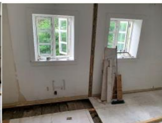
gavl, ingen tegn på sætning/ skade
