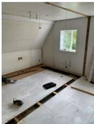
ingen tegn på sætning/ skade
