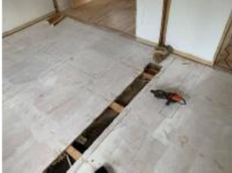
Opskæring gulv, aftegning nye vægge
