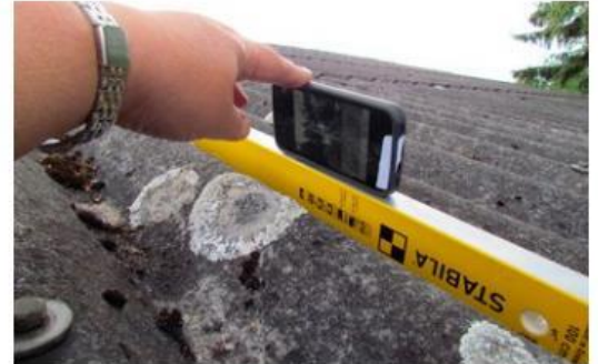
Måling af taghældning med en smartphone med app.
